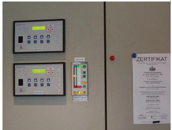
2 x ETAMATIC S elektronische Brennstoff-/Luftverbundregelung mit integrierter Drehzahlregelung des Verbrennungsluftgebläses und CO/O<sub>2</sub>-Regelung.
